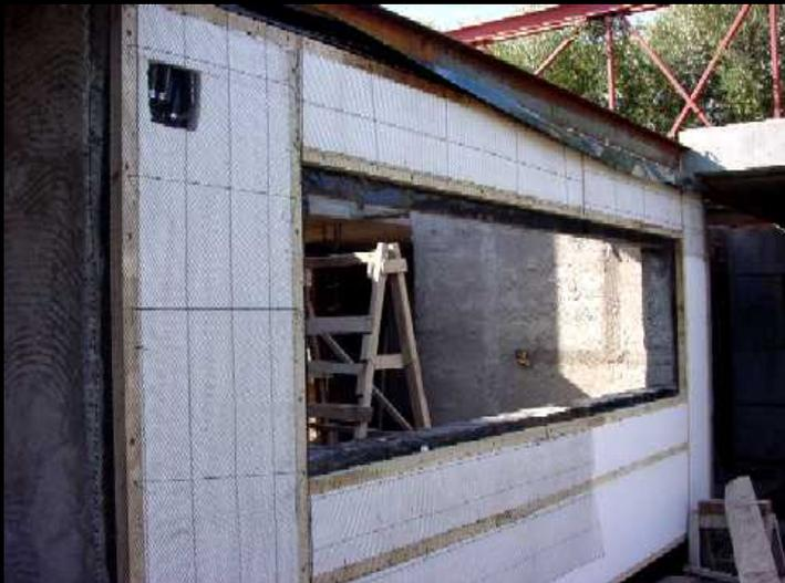
Muro de ladrillón con poliestireno expandido.
